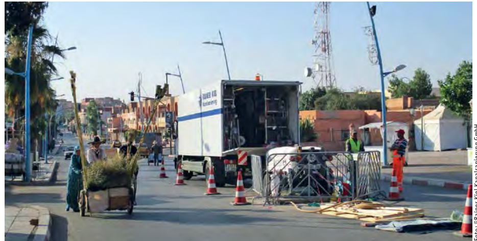
Sanierung im ca. 3.200 Kilometer entfernten Khénifra in Marokko
