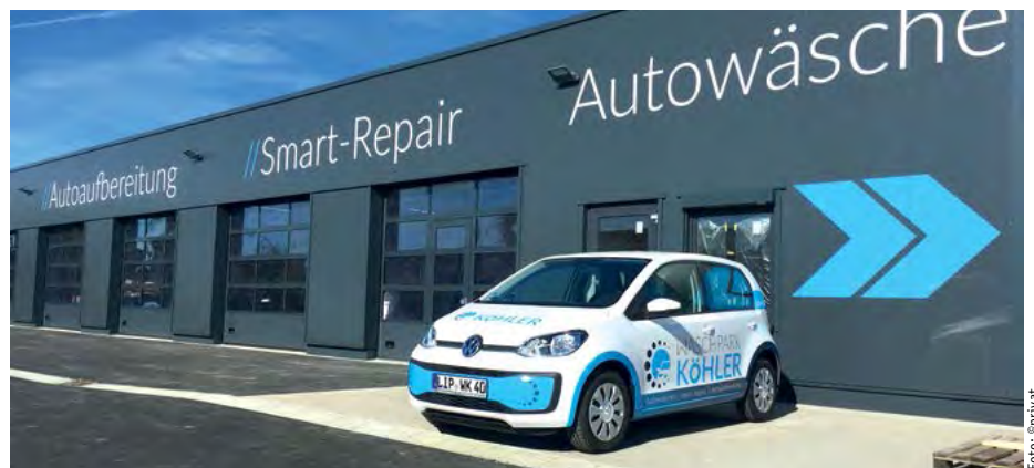
Der Waschpark mit Aufbereitungsangebot hat am neuen Standort viel mehr Platz
