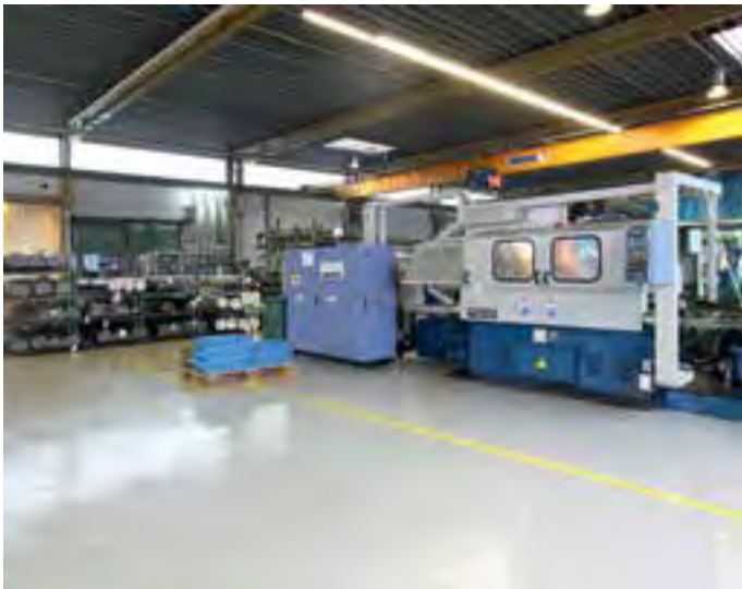
Der Industrieboden ist fugenlos sowie schlag-, kratz- und stoßfest
