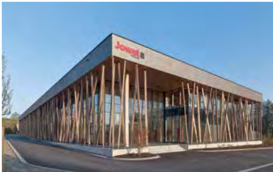
Nachhaltig: Das Haus der Technik. Das Gebäude ist in tragender Holzleimbauweise gebaut und in den 800 m³ Holz sind 750 t CO₂ gespeichert
