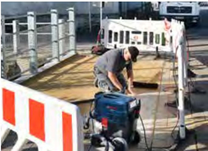
Brückensanierung: Schleifen des Untergrundes mit Staubabsaugung
