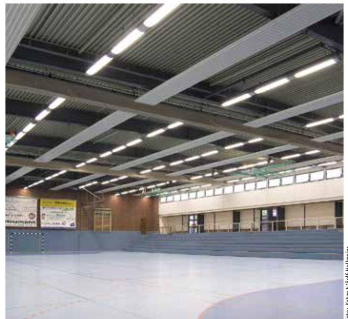
Evolution Sporthallenbeleuchtung – ballwurfsicher und dimmbar
