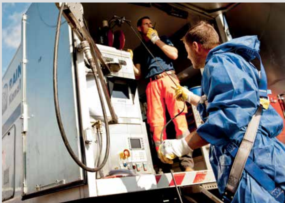
Foto: ©Rainer Kiel Kanalsanierung GmbH
